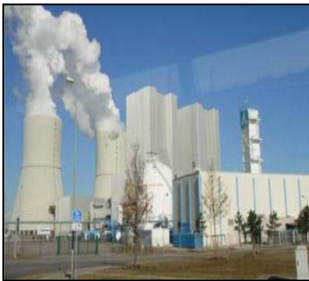
脱硫烟道、化工储罐
